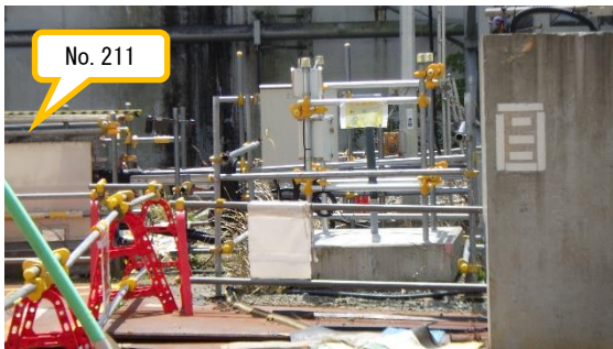
(写真3-2) サブドレンピットNo. 211の状況
