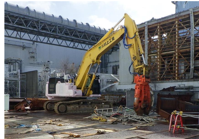
〈遠隔操作重機〉
