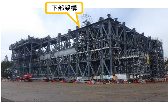
(写真 2 - 1) 下部架構の地組状況① (ヤード南側を北東側から撮影)
