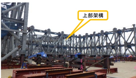
(写真 3 - 2) 上部架構の地組状況② (ヤード中央部を西側から撮影)
