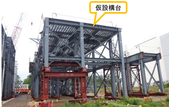
(写真1-2) 仮設構台の地組状況② (ヤード北側を南東側から撮影)
