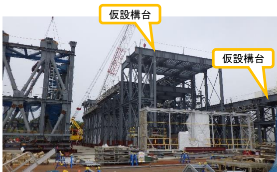
(写真1-1) 仮設構台の地組状況① (ヤード北側を南東側から撮影)
