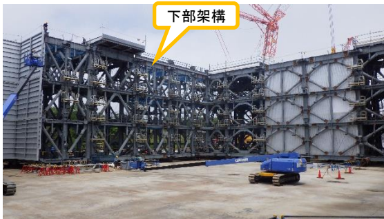
(写真 2 - 2) 下部架構の地組状況② (下部架構内部を南東側から撮影)
