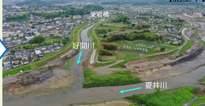
河道掘削状況【施工中】
