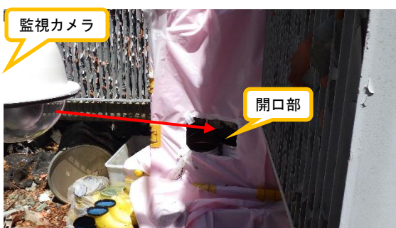
(写真 2 - 2) 接合部油漏えい箇所における遠隔での監視の状況②
