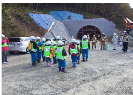
現場説明の様子
