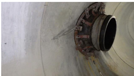
(写真2-2) 接続柵B推進配管(小口径ヒューム管)とD排水路下流側本管(大口徑ヒューム管)との接続状況 (下流側(東側)から撮影)
