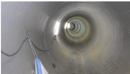
(写真1-2) 上流側推進管(大口径ヒューム管) 内部の状況 (東側(下流側)から撮影)
