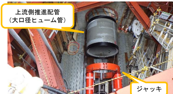
(写真1-1) 両発進立坑内の状況 (東側(下流側)上部から撮影)
