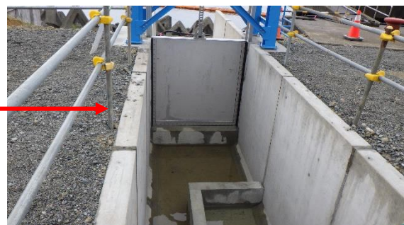
(写真3-2) D排水路開削水路の状況② (西側から撮影)
