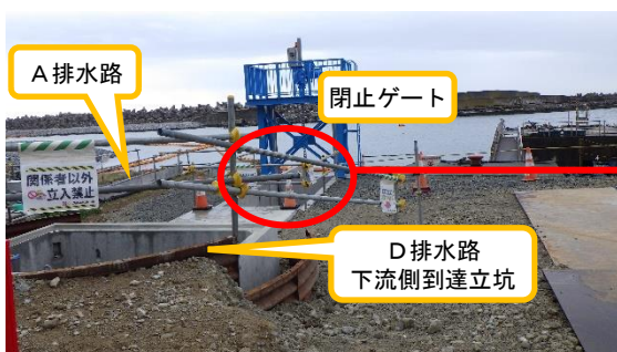
(写真3-1) D排水路開削水路の状況① (南西側から撮影)
