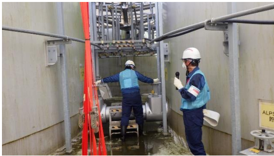
(写真3-2) タンクパトロールのデモの状況
