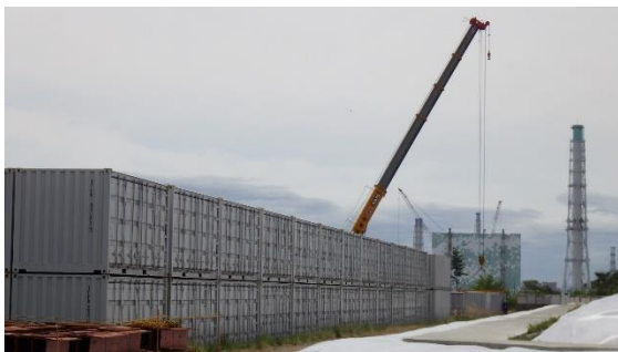
(写真2-1) 瓦礫類一時保管エリアAAの状況 ※写っている2段積みコンテナは 積み替え途中の状況とのこと。
