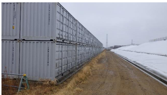
(写真1-2) 瓦礫類一時保管エリアAAの状況 (エリア北西側、南側に向かって撮影)
