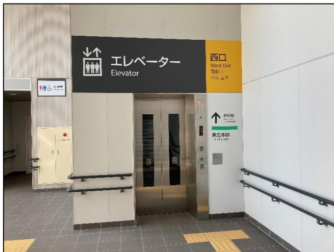
▲エレベーター
