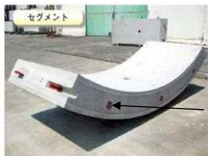
スクリーボルト継手 (接続部)
