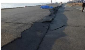
5号ふ頭4号岸壁
