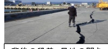
2号ふ頭1号岸壁
