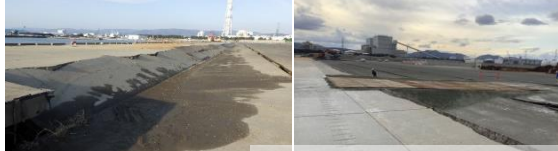
3号ふ頭岸壁(-12m、耐震)
