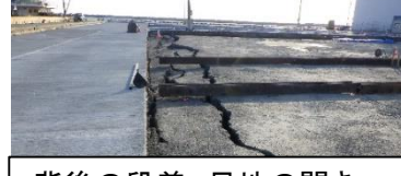
1号ふ頭6,7,8号岸壁
