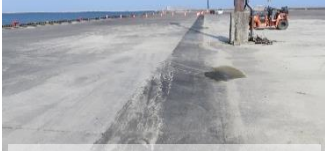
2号ふ頭4号岸壁
