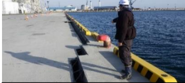
1号ふ頭1,2,3,4,5号岸壁
