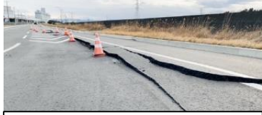
臨港道路5号ふ頭内線
