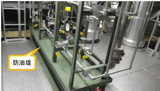
(写真 3) A系焼却炉バーナーユニット防油堤 及び周辺の状況
