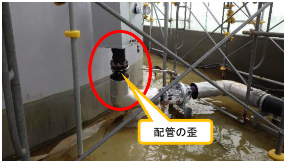
(写真5-2) 保温材を取り外した後の受入配管の 状況
