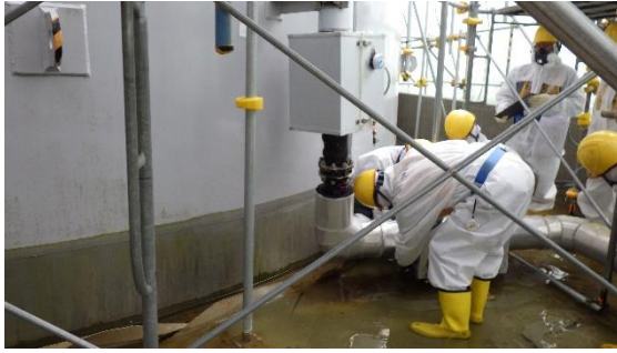
(写真5-1) 作業員による点検作業の状況
