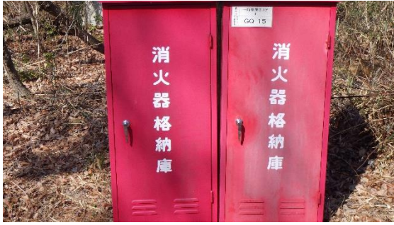
(写真2) 消火器の状況
