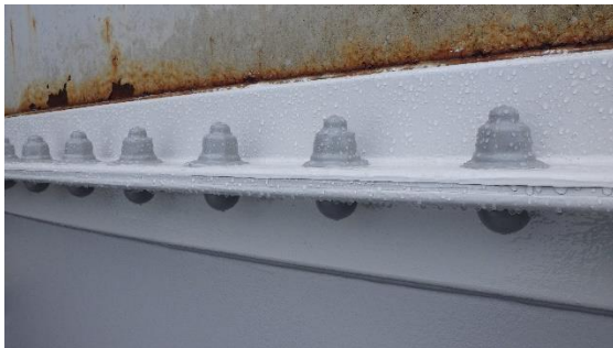
(写真3-2) 修繕されたタンクフランジ部の状況
