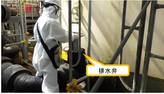
(写真5) タンク (B) の排水弁開放状況
