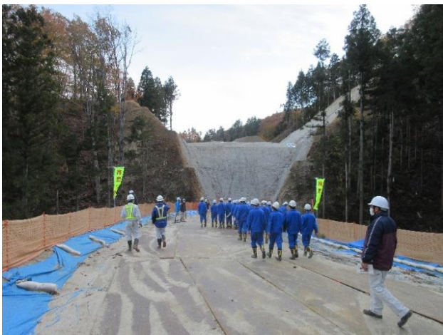
小島3期地区農道工事の見学
