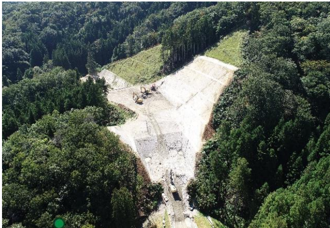
農道工事の様子 (小島3期地区)
