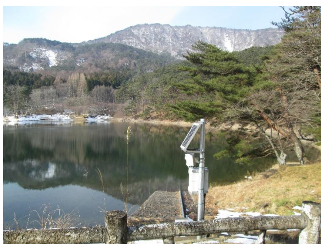
水位計及び監視カメラ
