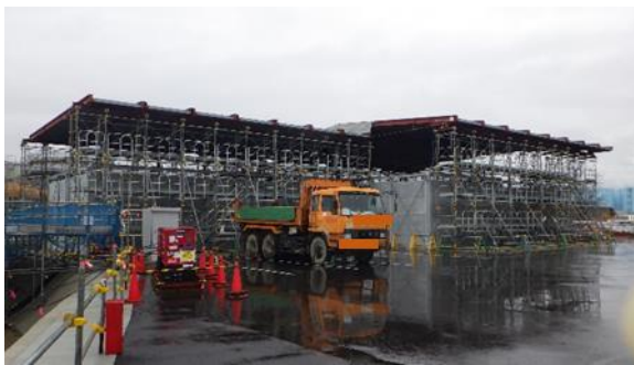
(写真1-1) 遮へい壁の外観 (北東側から撮影)
