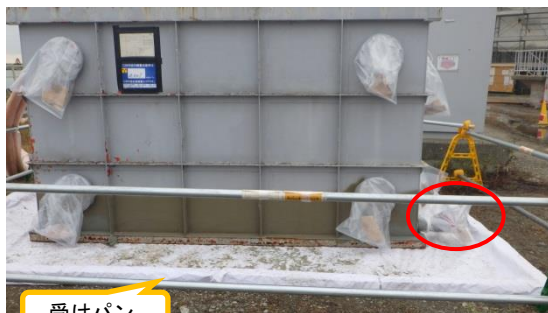
(写真2-1) 受けタンクの状況 フランジ部分が袋養生されている (赤丸部分が移送ホース接続部分)
