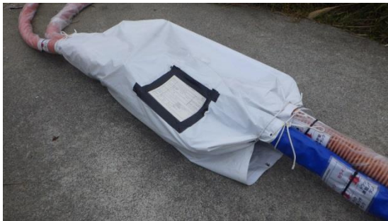
(写真1-2) 移送ホース継ぎ目部分の状況 受けパンが設置され、さらにシート で養生されている
