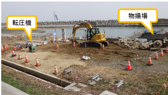
(写真2-1) 到達立坑建設現場の状況
