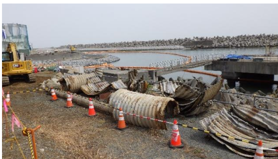
(写真2-2) 撤去された廃棄物の仮置状況
