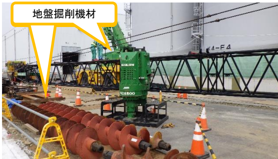
(写真1-2) 地盤掘削機材の搬入状況
