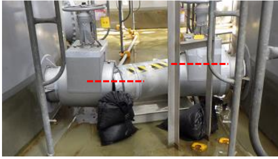
(写真 2 - 2) 位置ずれ（偏心）が最も大きい連結管
