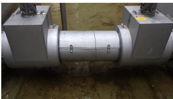
(写真2-1) 位置ずれが比較的少ない連結管
