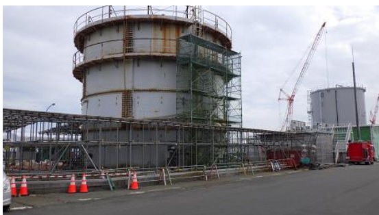
(写真4) 旧処理水バッファタンクの外観 （北西側から撮影）
