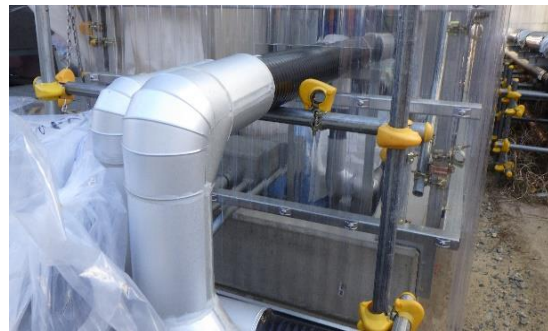
(写真2-2) 同左 コーキングが完了していた
