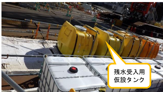
(写真4) 残水受入用仮設タンクの状況 (西側から撮影)
