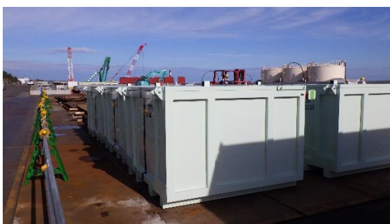
(写真3-2) 小割した残置カバーを詰めるコンテナ
