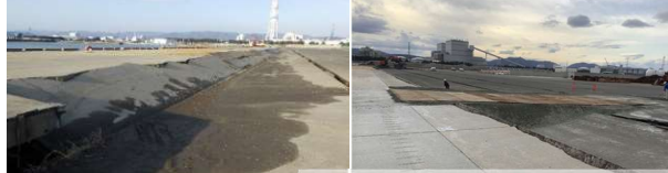
3号ふ頭岸壁(-12m、耐震)
