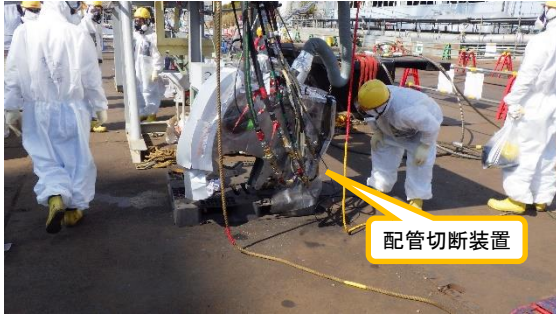
(写真 2 - 2) 配管切断装置の調整の状況
