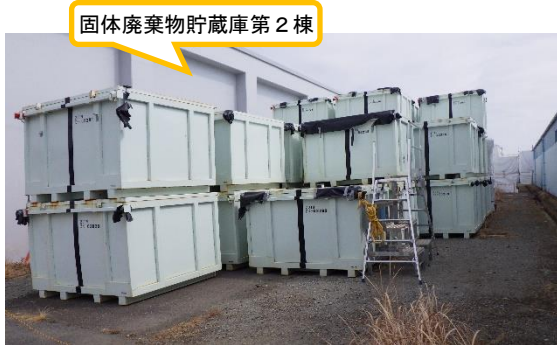
(写真5-1) 一時保管エリア n の固体廃棄物貯蔵庫第1棟と第2棟の間におけるコンテナ保管状況 (西側から撮影)
