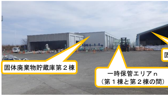
(写真4) 一時保管エリア n の概観 (西側から撮影)
