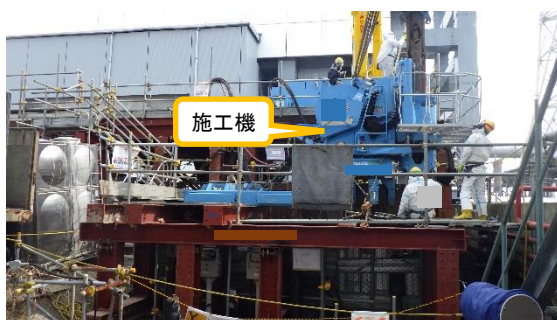
(写真2-1) 先行掘削終了時の状況① (西側から撮影)
