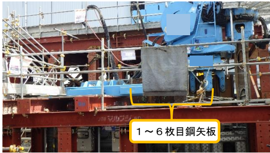
(写真 2 - 2) 先行掘削終了時の状況② (西側から撮影)
