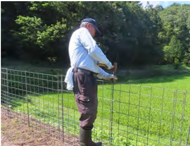
図1 設置（杭の打込み）の様子
