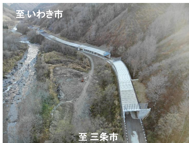
スノーシート工事状況
