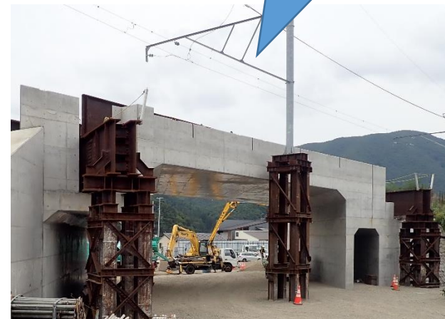
南会津町田島地内
