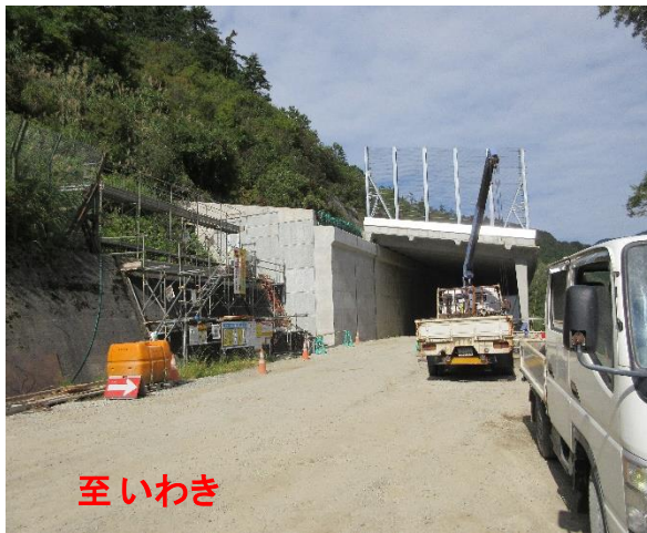
スノーシェッド工事状況
