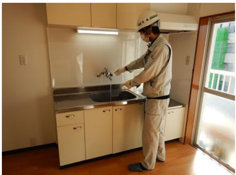
↑施工に不具合がないか、現場の確認を行います。
