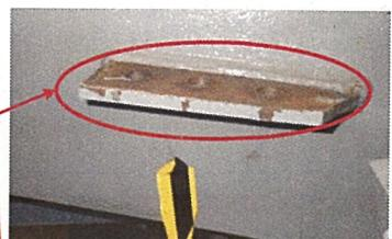
接合部のボルトが破断
