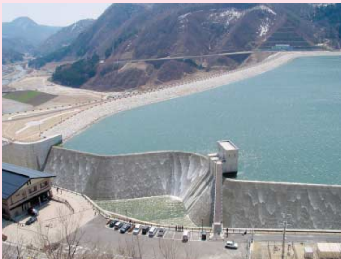
摺上ダム最高水位到達時（試験湛水） 写真提供：国土交通省
