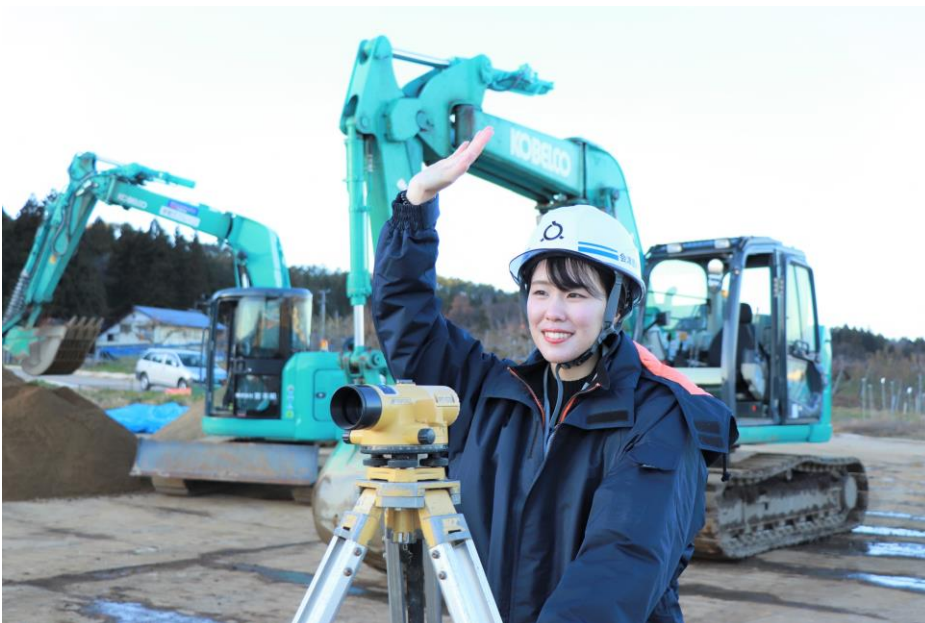
↑パイプライン工事の埋設高さを確認している様子。
