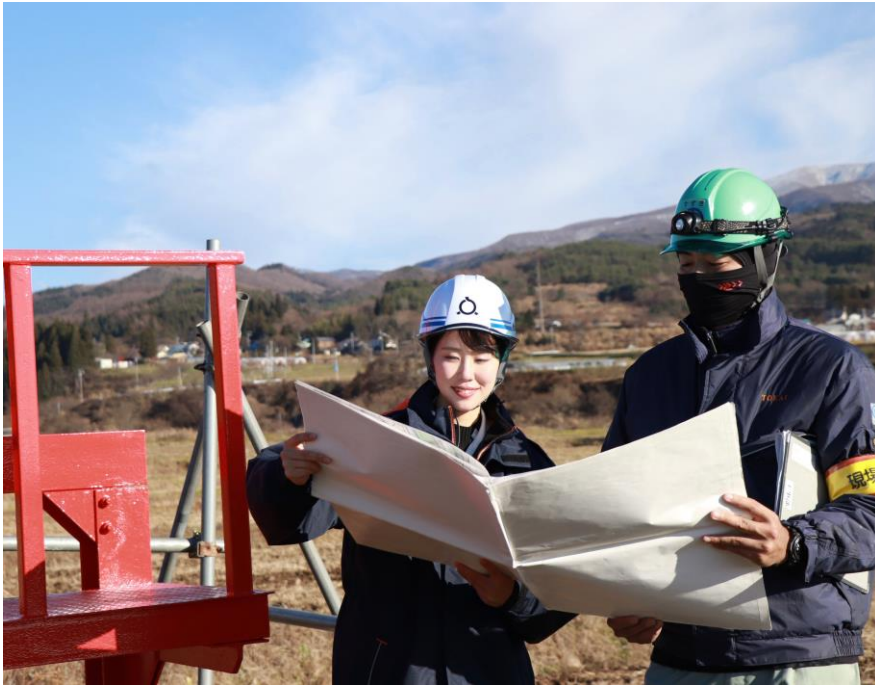
↑ 水門工事の施工状況について現場代理人と確認している様子
