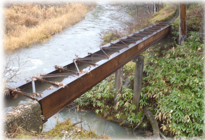
仮安沢水路橋（只見町）
