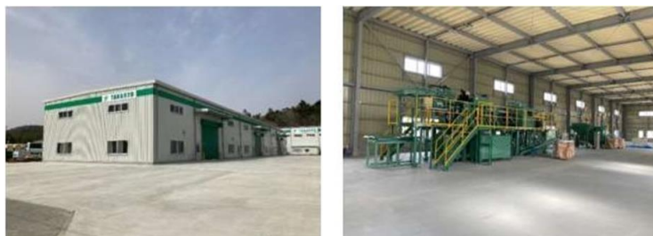
図：太陽光パネルリサイクル施設（提供：㈱高良）
