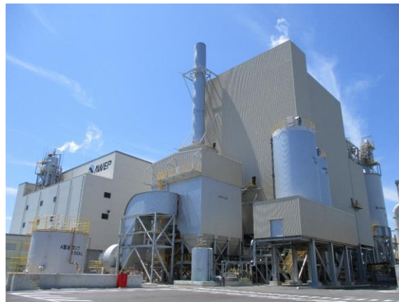
写真：エア・ウォーター&エネルギー・パワー小名浜バイオマス発電所 （2021年4月営業運転開始）（提供：エア・ウォーター㈱）
