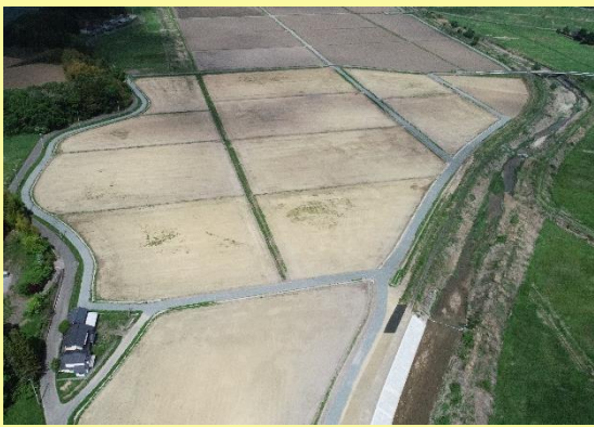
令和 3 年度復旧状況
