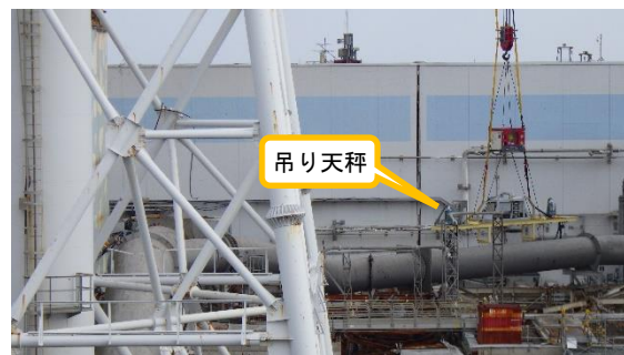
(写真 3 - 2) 配管切断箇所に移動された吊り天秤
