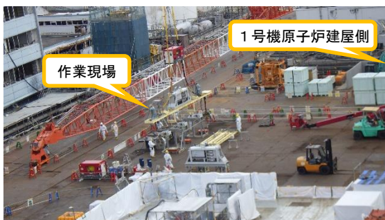
(写真2-1) 1号機原子炉建屋西側の現場の状況
