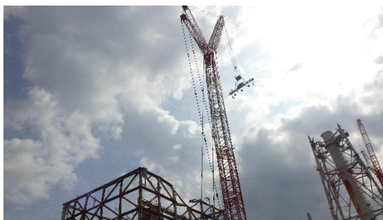
(写真 3 - 1) 吊り天秤の移動の状況
