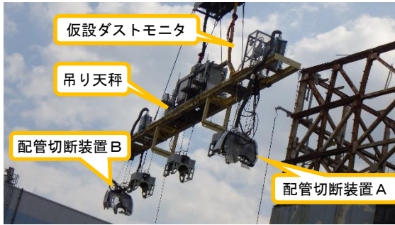
(写真 2 - 2) 吊り天秤の状況
