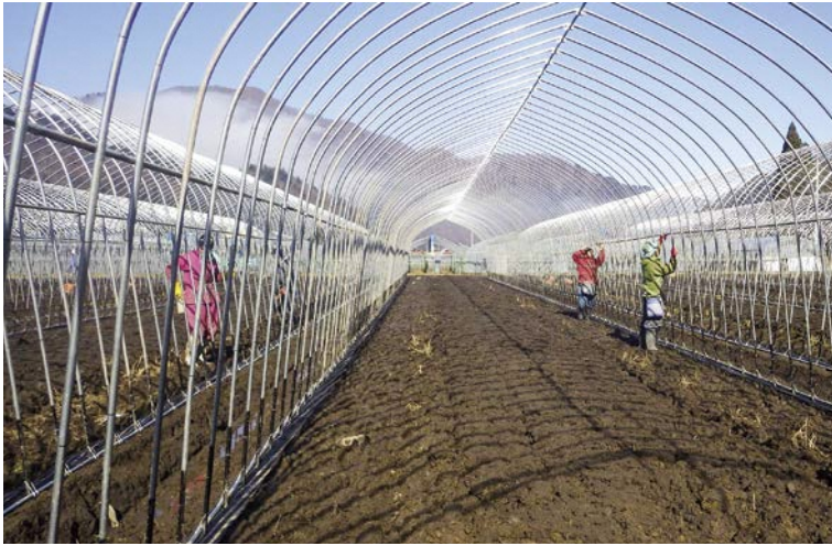
写真1 パイプハウス設営の様子
