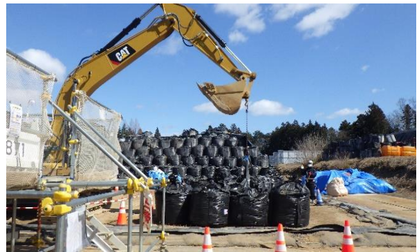
除去土壌等の積込作業
