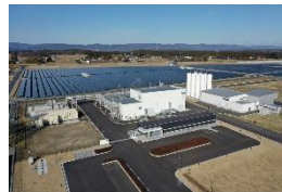
福島再生可能エネルギー研究所
