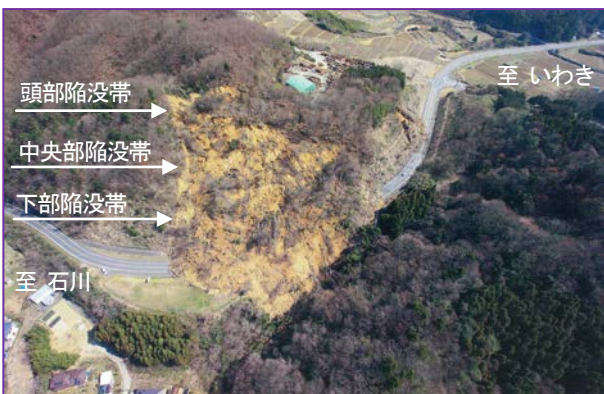
写真-1 被災状況
