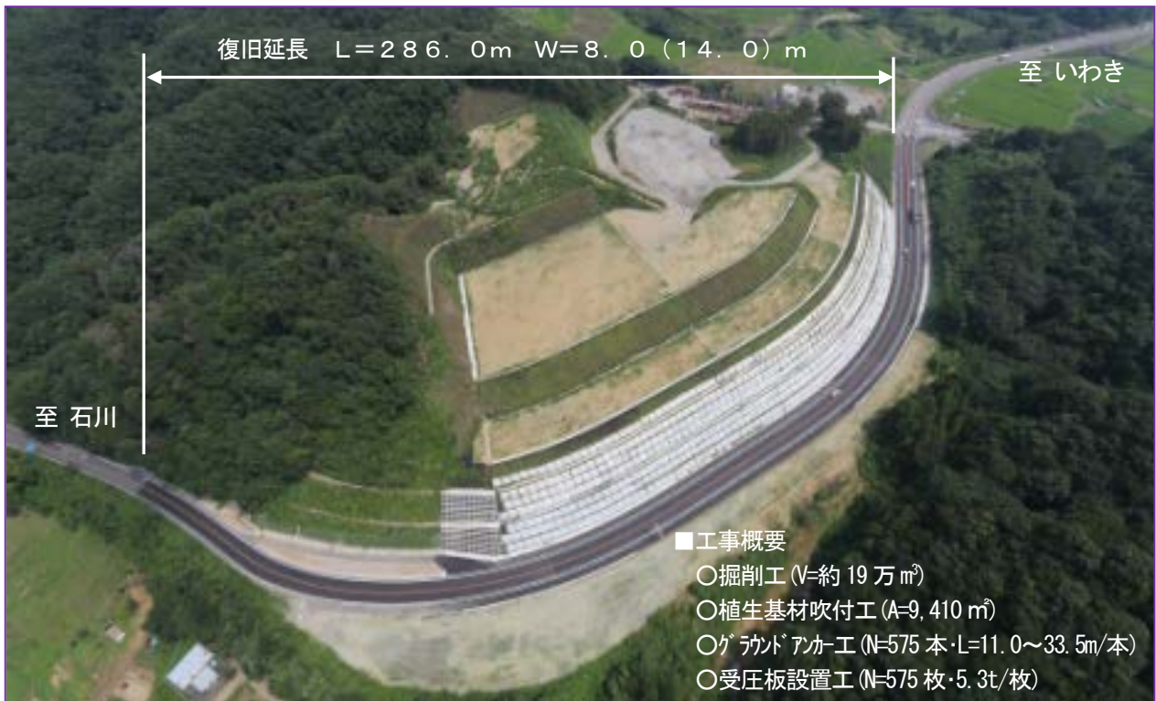
写真-21 本復旧工事完成 (2013年8月28日)
