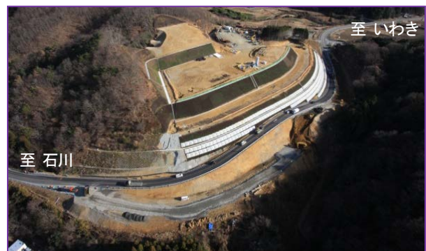
写真-10 第2段階の供用状況 (2012年12月)
