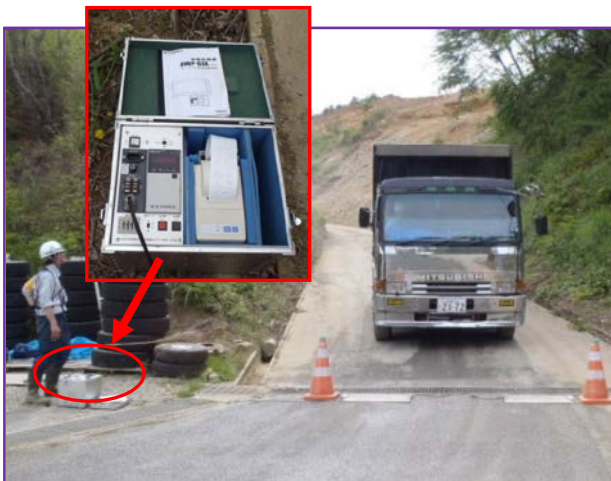
写真-16 トラックスケールの設置
