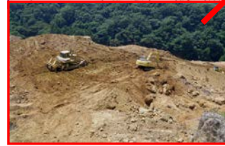
写真-5 頭部排土状況
