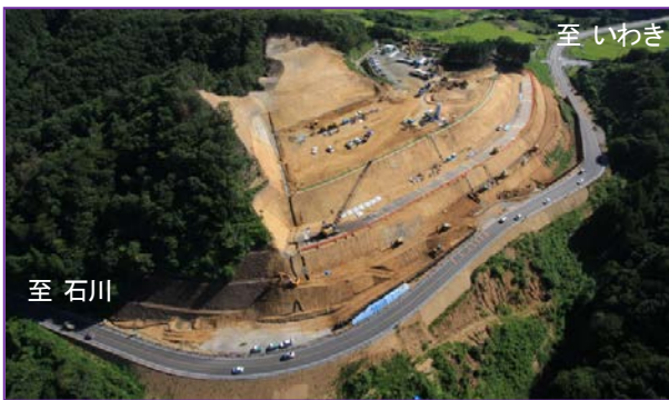
写真-9 第1段階の供用状況 (2012年8月)
