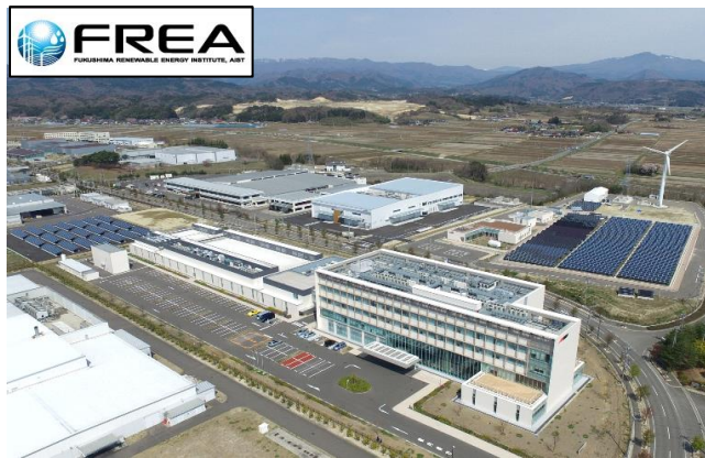
691 福島再生可能エネルギー研究所（提供：FREA） 692 693 694 695 696 697 698 699 700
