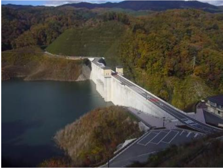
木戸ダム（檜葉町）
