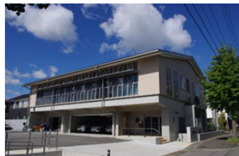
福島県須賀川土木事務所 (庁舎としては東北で初めて Nearly ZEB 認証を取得)
