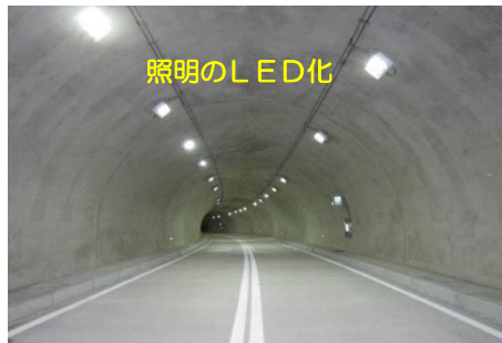
LED 事例（国道 252 号 滝トンネル（金山町））
