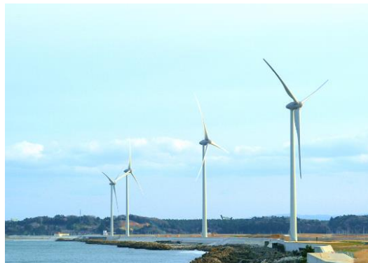
万葉の里風力発電所（南相馬市）（提供：南相馬サステナジー）
