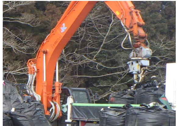
除去土壌等の積込作業
