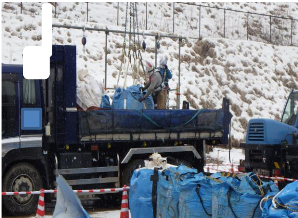
除去土壌等の積込作業
