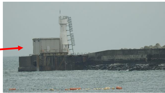
(写真1-2) 海水放射線モニタ建屋の状況 (東波除堤から撮影)
