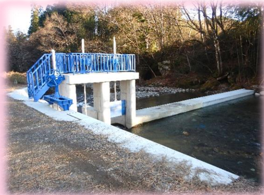
完成した取水ゲートと土砂吐ゲート(上流側より望む)
