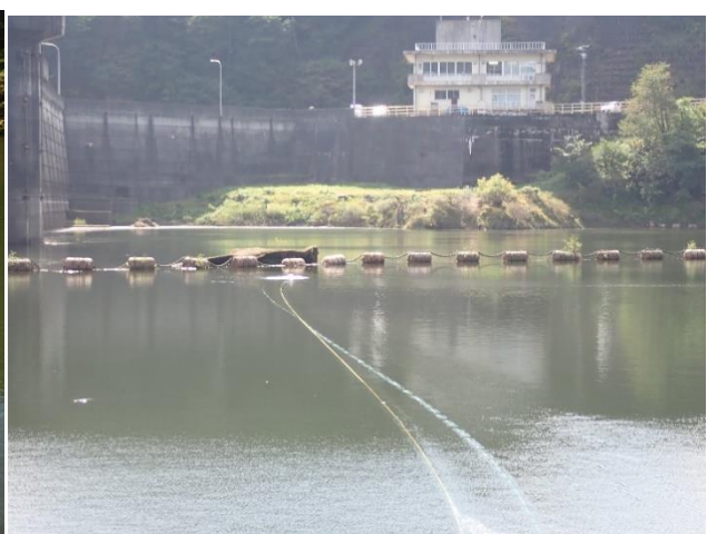
水中ドローンによる網場(あば)やゲートの調査
