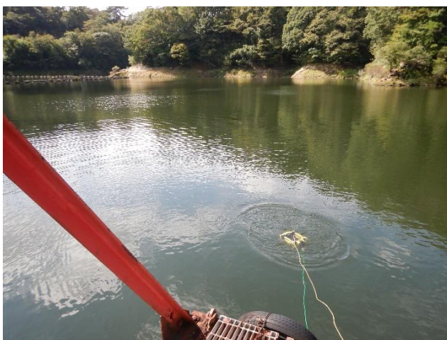
水中ドローンによる網場(あば)やゲートの調査
