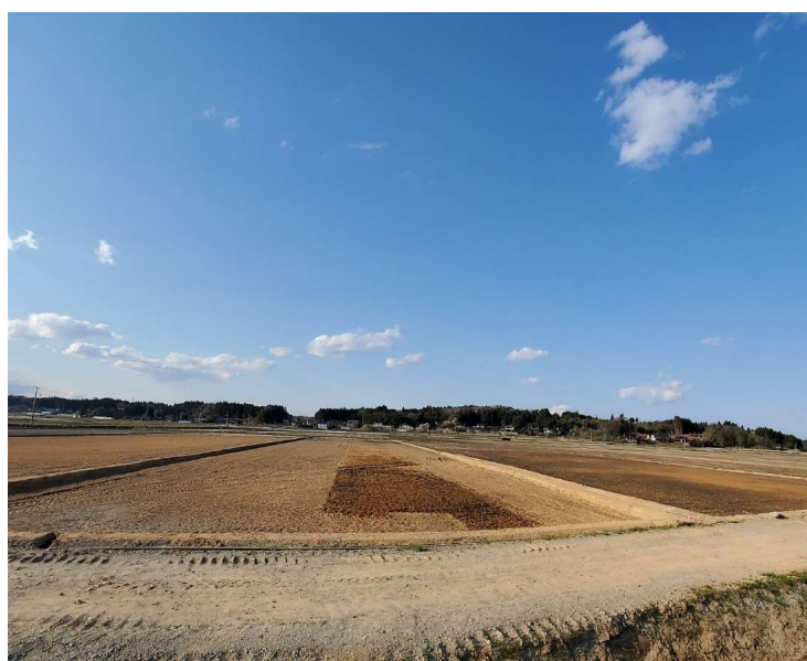
【復旧状況 整地完了】
